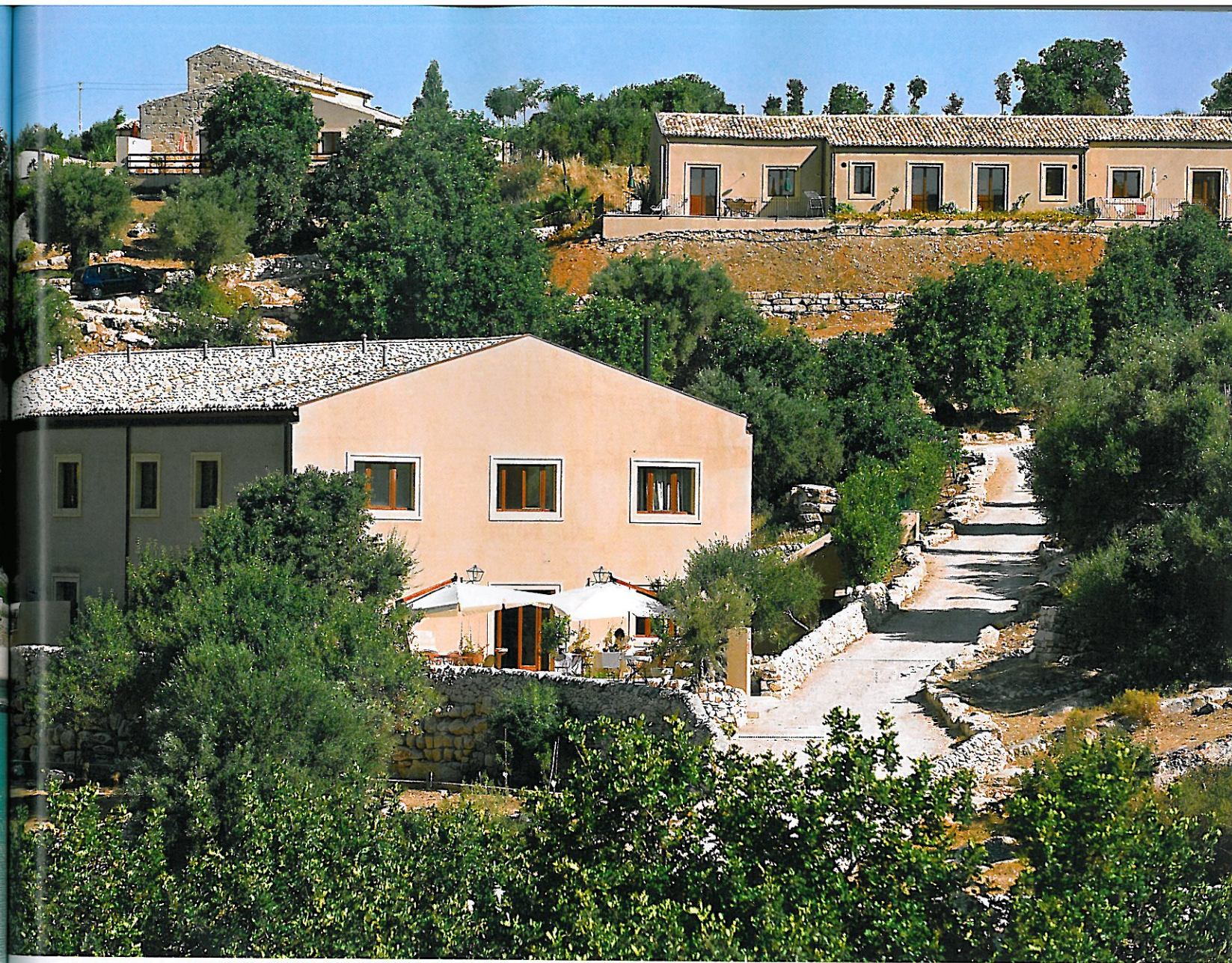
Le strutture di accoglienza del Relais e, a sinistra, le piscine ricavate nella roccia
